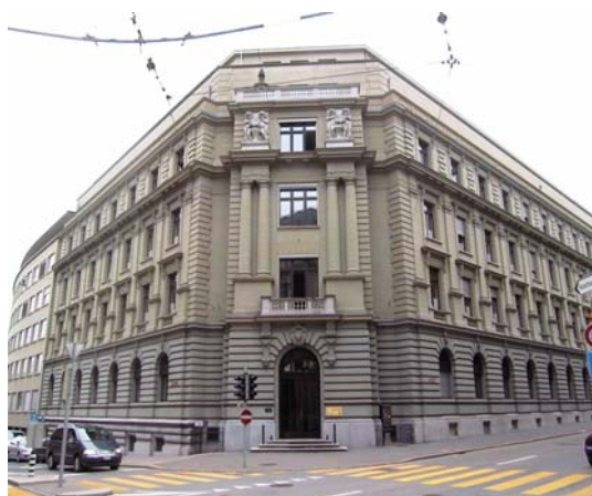
La Maison des cantons à la Speichergasse 6 à Berne sera occupée dès juin 2008.
