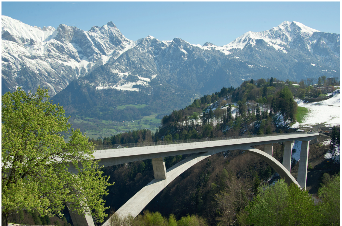
Taminabrücke, Kanton St. Gallen (© Kanton St. Gallen, Tiefbauamt)
