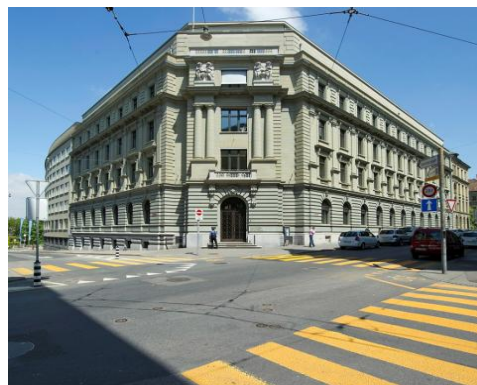
Maison des cantons, Speichergasse 6, Berne
