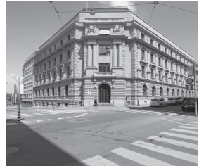
Maison des cantons, Speichergasse 6, Berne
