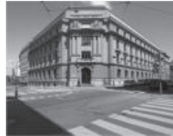
Maison des cantons, Speichergasse 6, Berne
