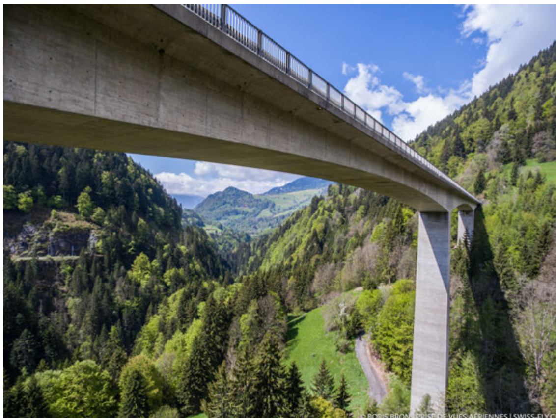
Pont d'Aigremont - Ormont-Dessous (VD) © SWISS-FLY Prise de vues aériennes, Boris Bron
